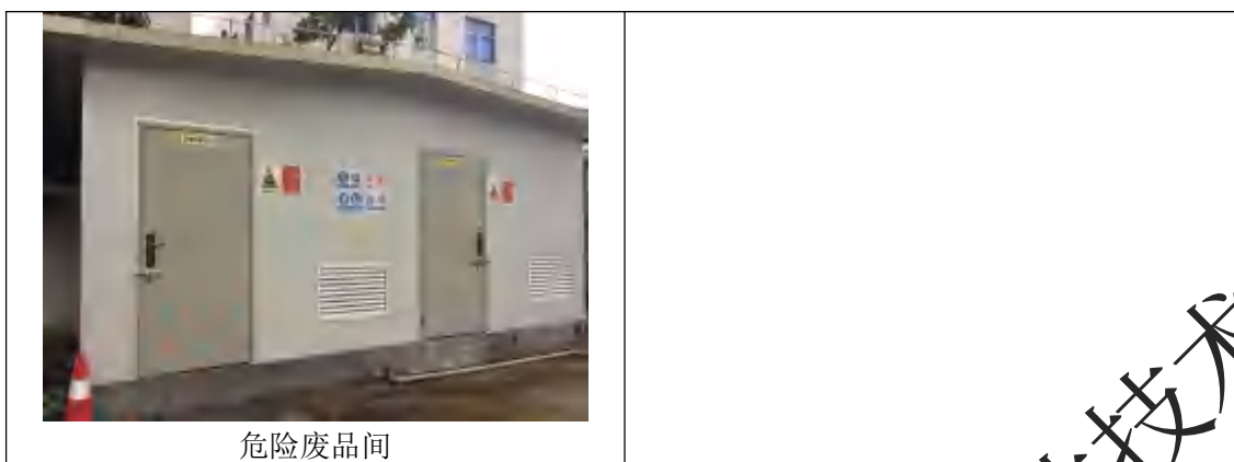
图3.2-2 现有工程相关环保设施实景图
